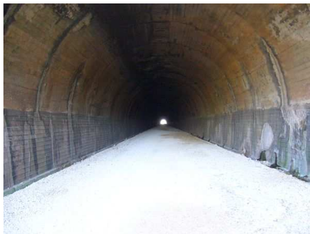
Túnel ferroviario de Modúbar de la Emparedada
